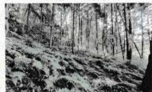
写真⑥ 地すべり地内
