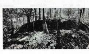
写真⑧ 右側壁亀裂状況
