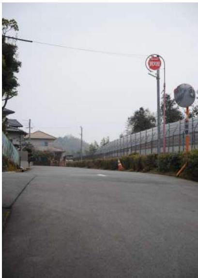
完成した4東地区の遮音壁工事
