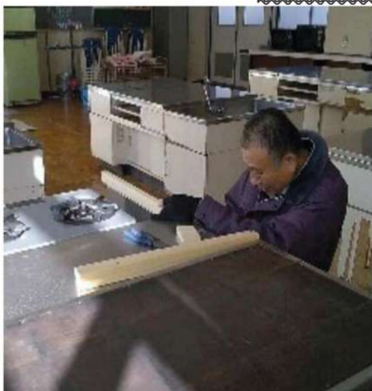
日吉台小の調理台をボランティアで工事をする岸本さん
