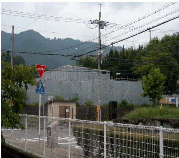
こども園設置に向け解体工事が進められる旧日吉台幼稚園
