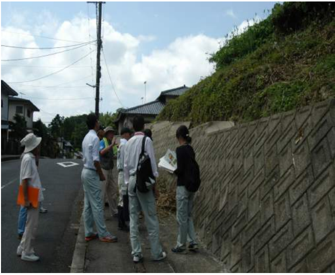
2北地区の地すべり現場を調査する県、市係官
