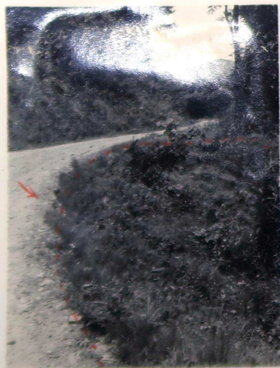
前宇夏竹林の上は布道で約50cm落差の亀裂あり
