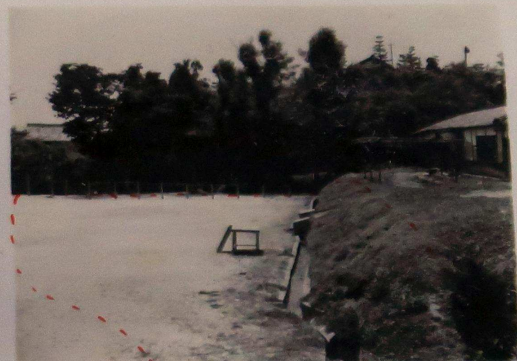
小学校々庭 - 鉄棒より手前 台に かけて隆起し、水路の屈曲状、現るわがさ。 右側土手に杭が打込まれてある。
